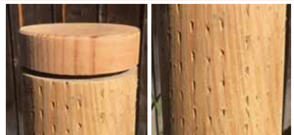
ポストキャップ(雨滴による頭頂部損傷防止) インサイジング加工(防腐剤浸潤)
