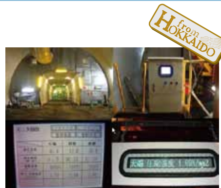
■「積算温度強度管理システム」実現場の使用状況
