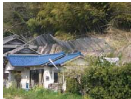
■プラクトフェンス民地際設置状況
