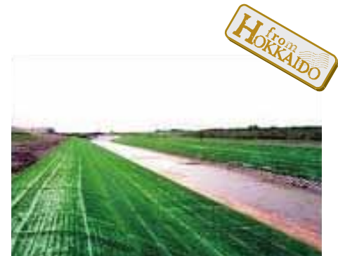
■施工1ヶ月の状況
