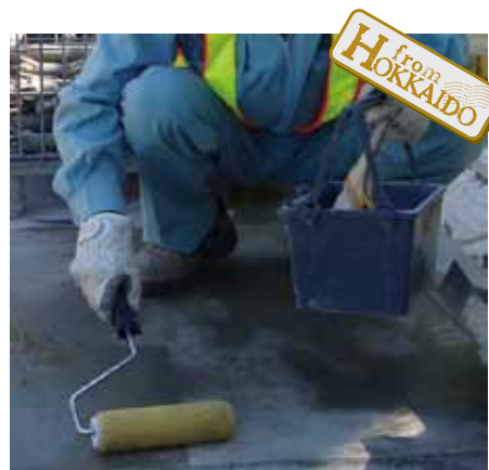
■Osmo建築防水用塗布状況
