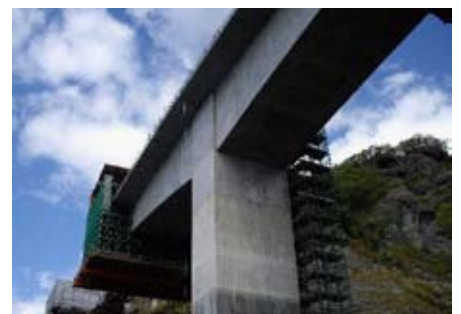
■サーモセイバーを使った橋梁上部工
