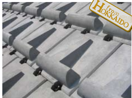
■設置連結状況
