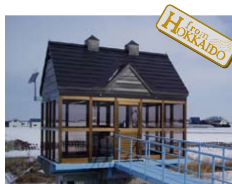
■左岸東8号樋門(石狩川開発建設部)
