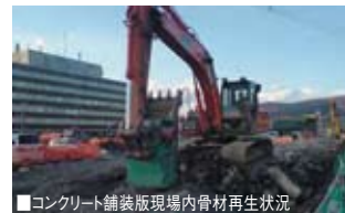
■コンクリート舗装現場内骨材再生状況
