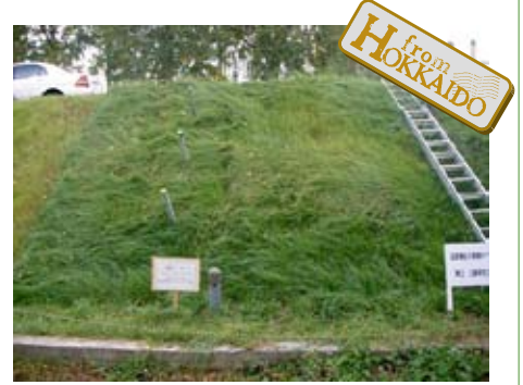
■動植物残渣堆肥を基盤材とした植生工の生育状況
