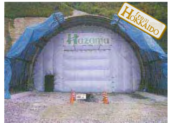
■隔壁バルーン (坑口への設置例)
