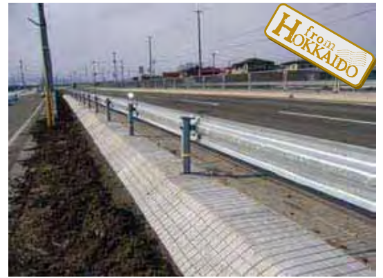
■マルチマット施工後
