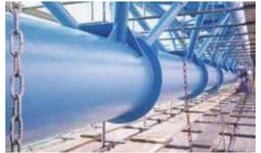
■水管橋施工写真
