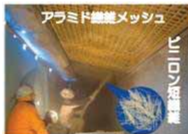
施行状況(橋梁)
