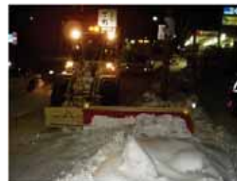
間口機械施工 (ロングスライドブレード)
