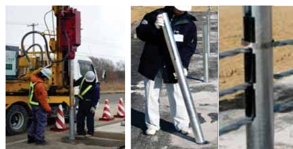
スリーブ打込み、支柱建て込み、ワイヤ設置
