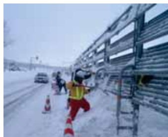
柵下従来施工（人力施工）
