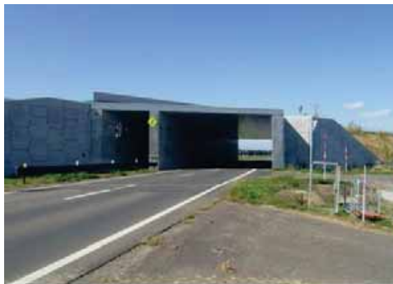
複合構造横断函渠工の施工状況
