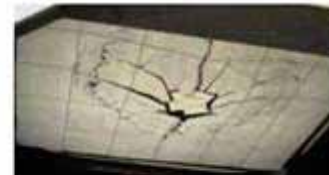
本補修補強工法
