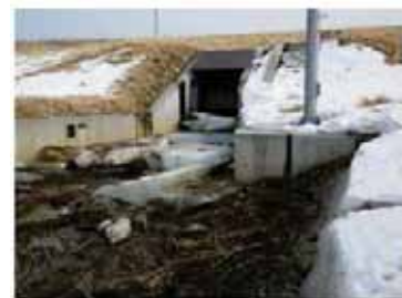
津波が河川を遡上した後、樋門の門扉下に堆積する氷板
