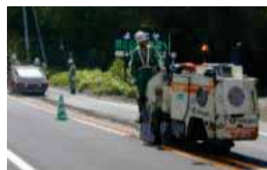
ランブルストリップス施工状況
