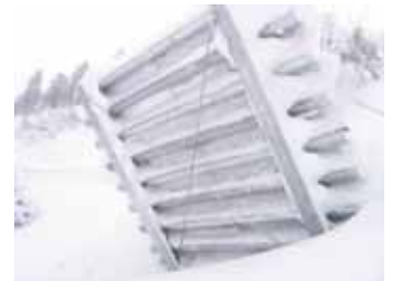
ネット工によるすり抜け対策例
