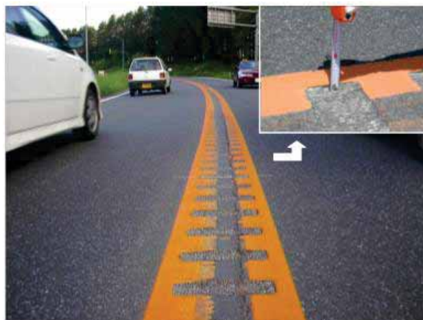
ランブルストリップス（国道237号上富良野町）
