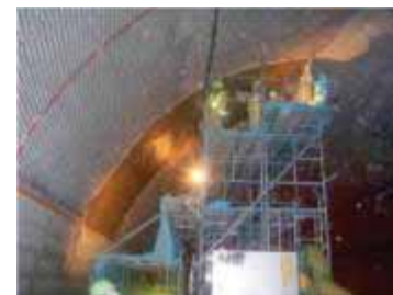
施行状況(トンネル)
