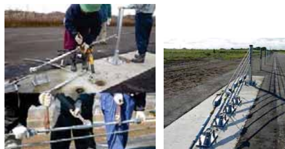
金具類装着、ワイヤ張力の調整、完成
