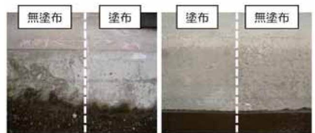
塗布1年後の地覆（道央） 塗布4年後の地覆（道東）
