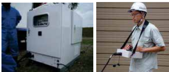
操作盤及びコントローラ
