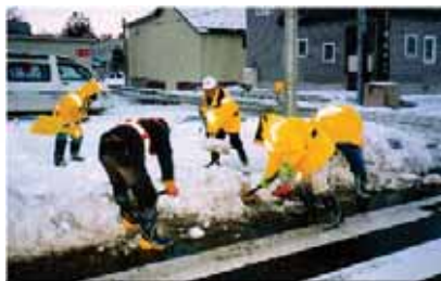
間口従来施工（人力施工）
