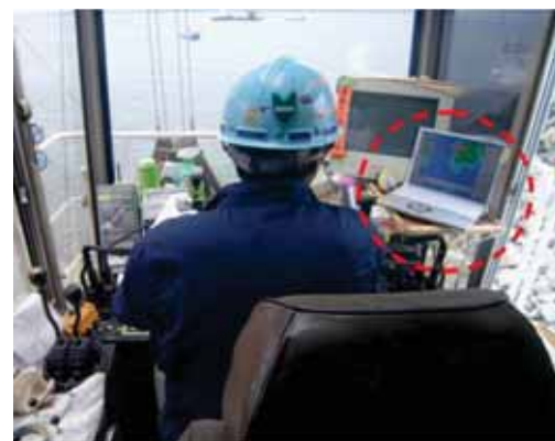
装置を用いた捨石投入状況
