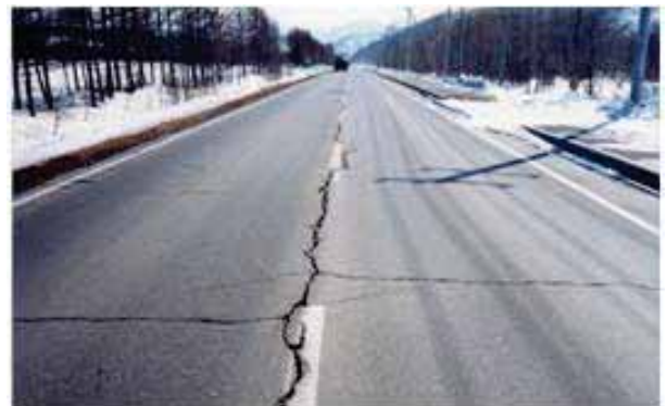
凍上によるひび割れ
