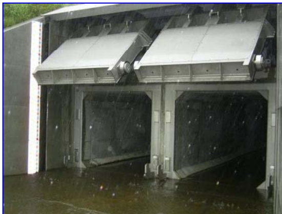
門柱レス樋門の例
