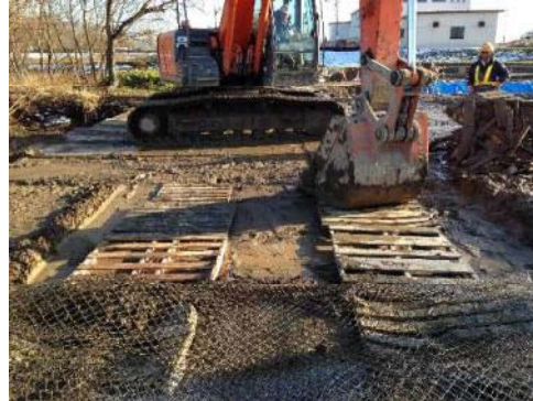
ステップ2 廃材パレット設置および均し
