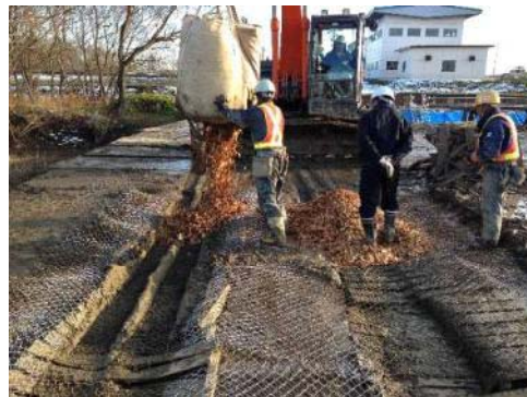
ステップ5 緩衝材としての 木質チップ敷き均し
