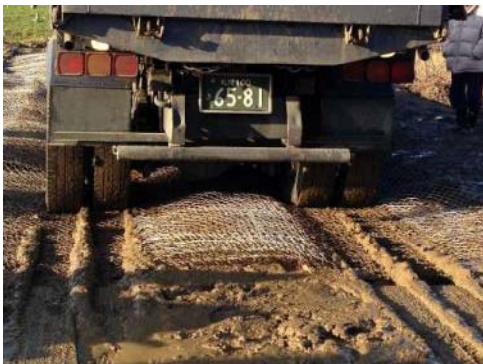
ステップ4 重機(ダンプトラック) による均し
