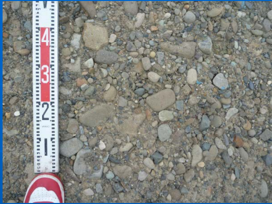
ふるい工区 (浄水汚泥・堆肥種子吹付工 t=3\text{cm} ) A工区
