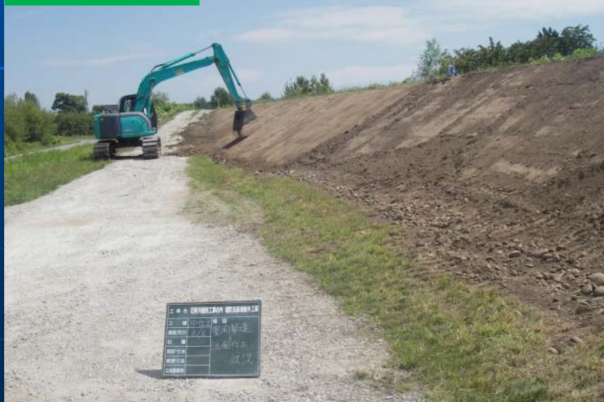
②法面整形
