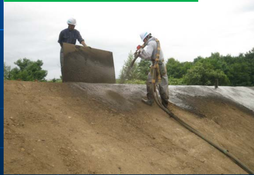
③浄水汚泥・堆肥種子吹付工
