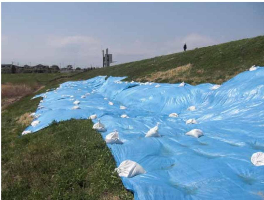
ボンテラン改良土を用いた築堤箇所
