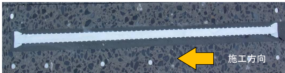
鉄筋周りへの充てん状況
