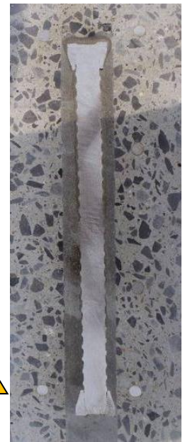
鉄筋周りへの充てん状況
