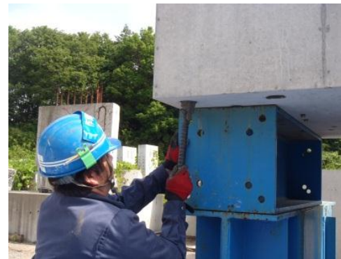
上向きの施工
