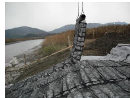
(7) 吊上げ・本設置
