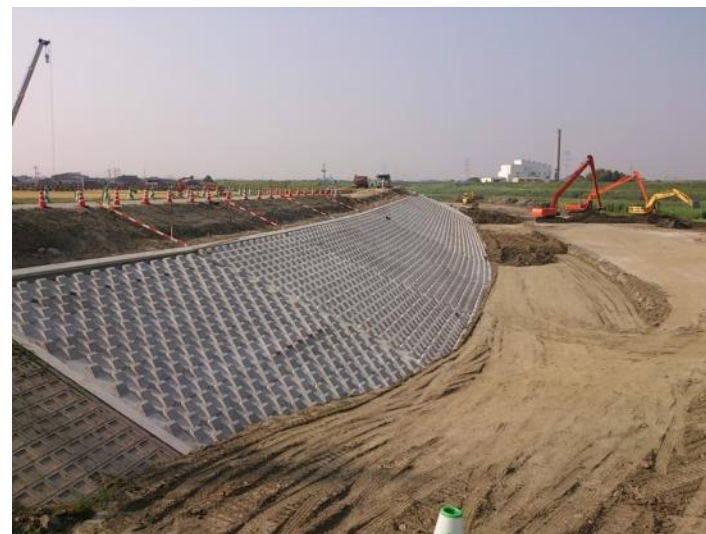
堤防復旧状況
