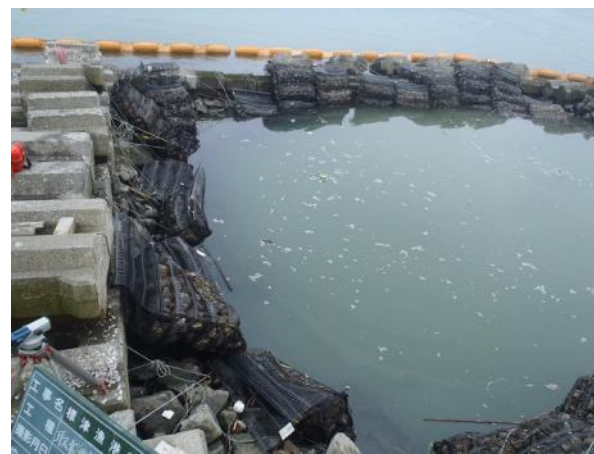
②ジオシェルトン仮による法面崩落防止状況
