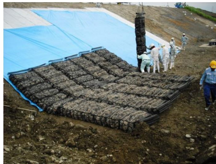
敷設状況(近景)
