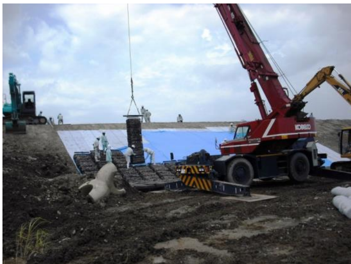
敷設状況(全景)
