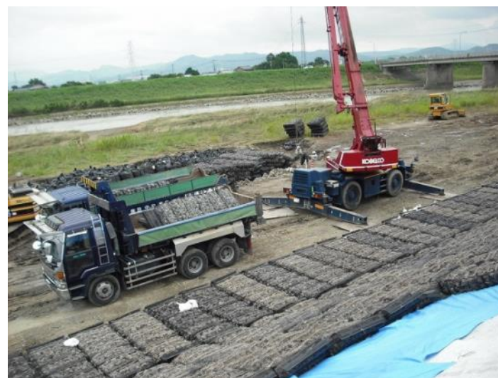
敷設状況(全景)
