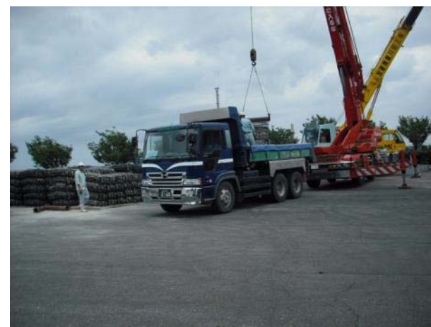
備蓄ヤードからの運搬状況
