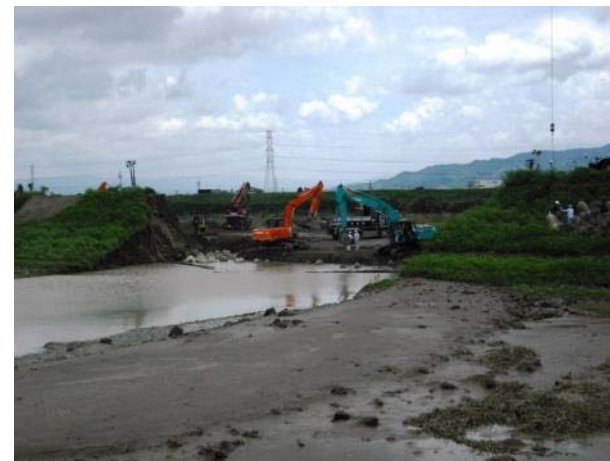
仮設盛土復旧状況
