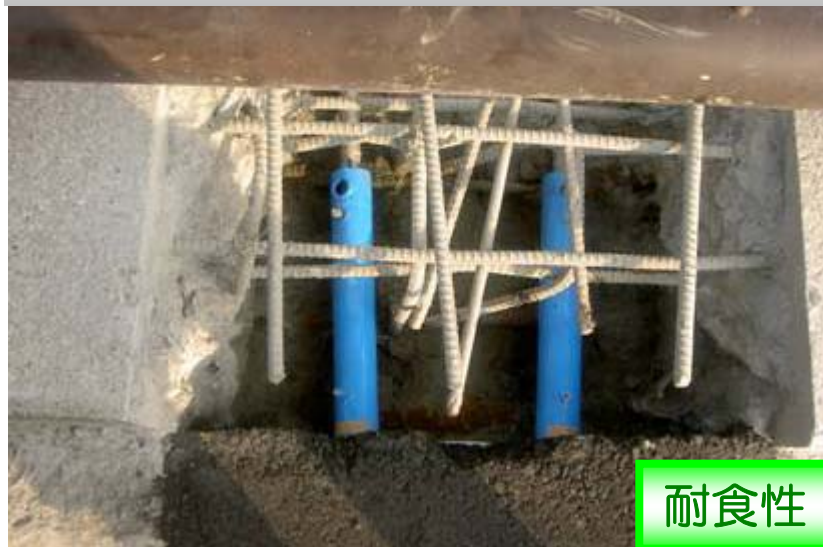
橋梁・普通鉄筋との機械継手
