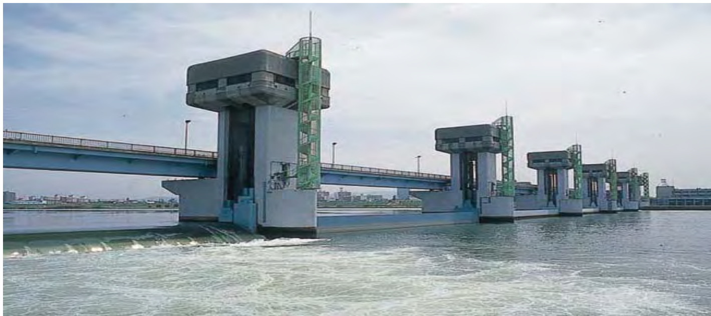
洪水時に開けるべきゲート設備(堰)
