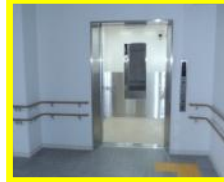
車いす対応のエレベーター
