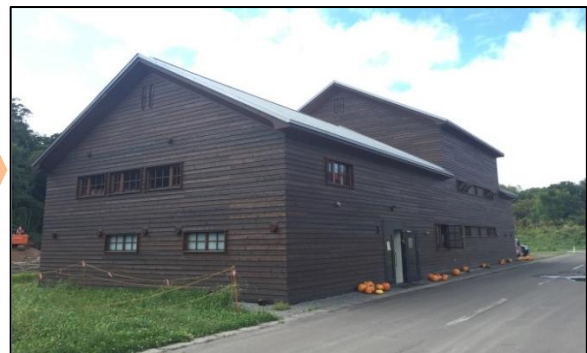
改修後の旧でんぷん工場
