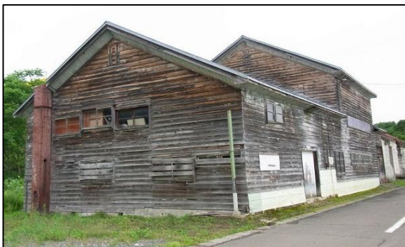
改修前の旧でんぷん工場
