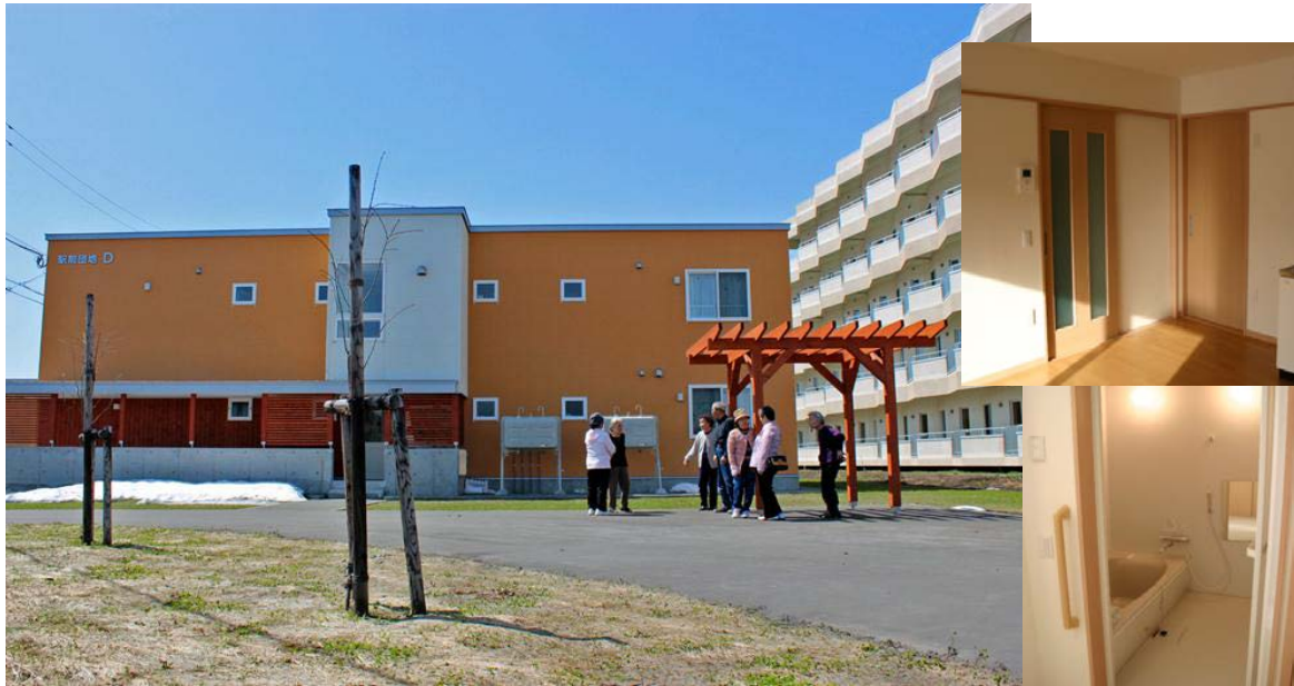
写真左：コミュニティ広場【地域住民との交流の場】、 スロープの雁木と自転車置場のルーバーにも地場産材を活用し景観を創出（屋外化部分） 写真右上：食堂【高齢者対応：引き戸で有効開口幅を確保】、写真右下：浴室【高齢者対応型】
