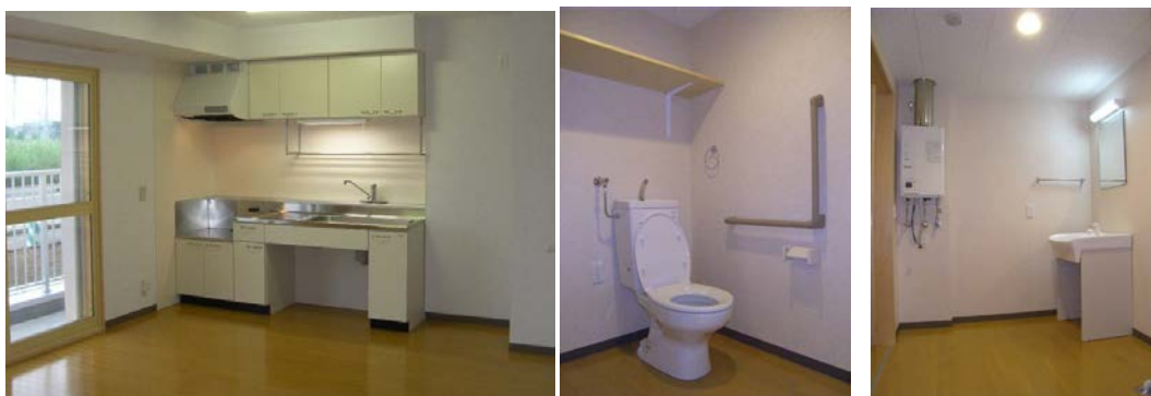
写真左：食堂・台所【高齢者対応：車いす対応の流し台】
