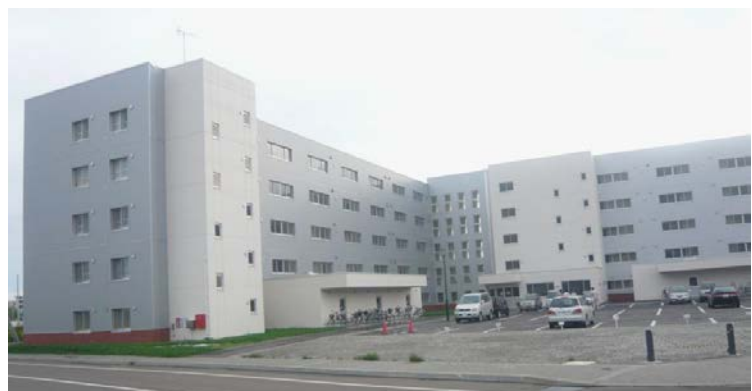
外観（東面）【堆雪スペースの確保】
