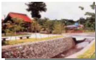
道路・公園等の整備
