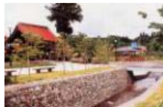
道路・公園等の整備
