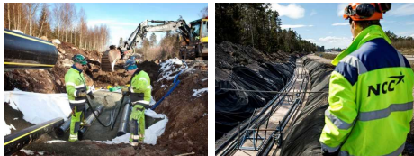
新規の高圧電線地中化
