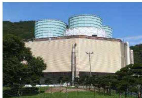
北海道電力(株) 森地熱発電所
