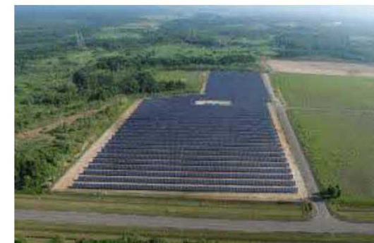
シャープ苫小牧第一太陽光発電所（出典：シャープ）
