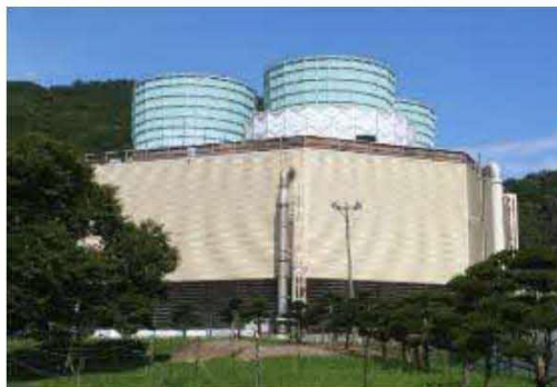
北海道電力(株) 森地熱発電所
