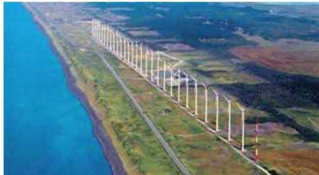
オトノレイ風力発電所、幌延風力発電(株)（出典：NEDO）
