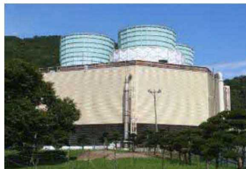
北海道電力(株) 森地熱発電所
