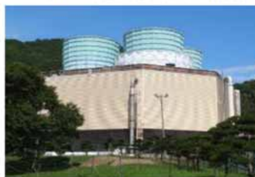
北海道電力(株) 森地熱発電所
