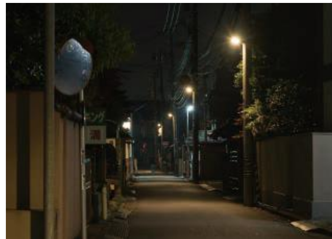
LED化された防犯灯
