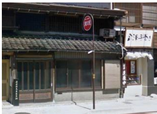
消火栓標識柱をシティブラウンに
