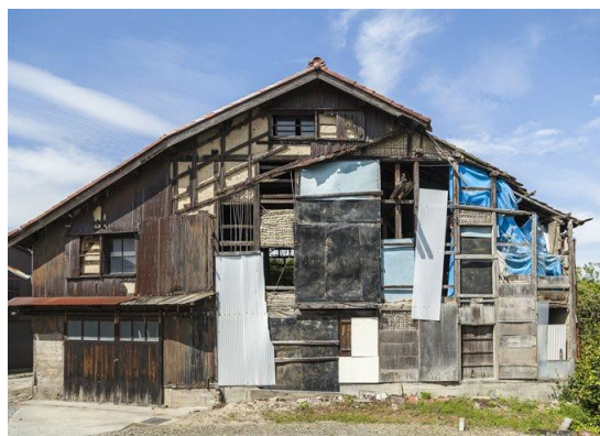
放置された建物
