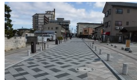
無電柱化、石張舗装、歩道整備
