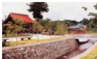
道路・公園等の整備
