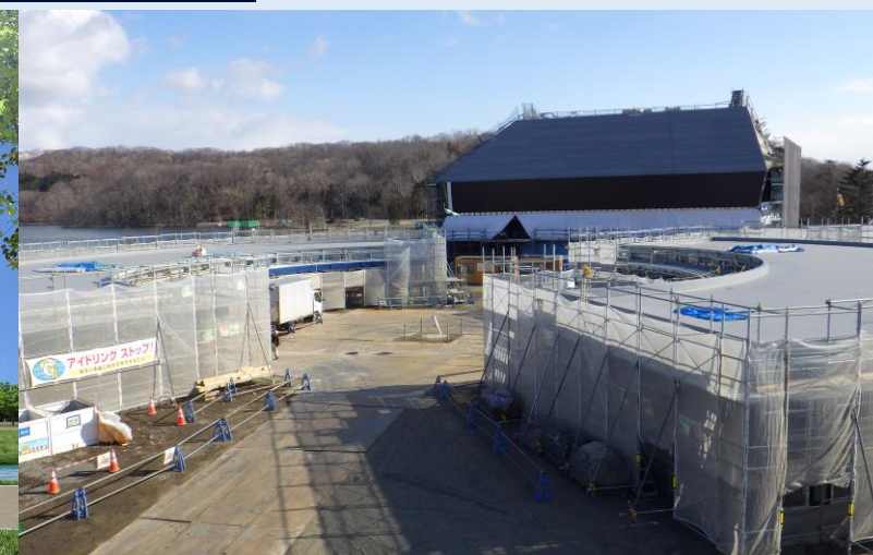
(写真提供:国立民族共生公園 エントランス棟建築工事) 現状写真
