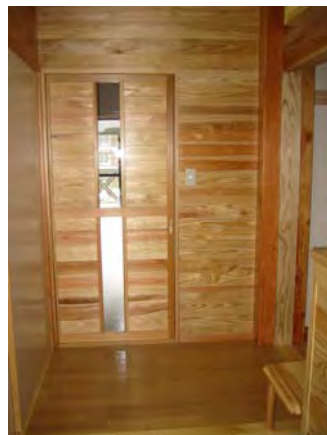
県産のスギを使用した玄関 (秋田県手形山1号団地)
