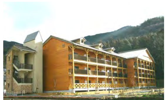
県産のスギを使った外壁 (兵庫県営八千代下野間住宅)
