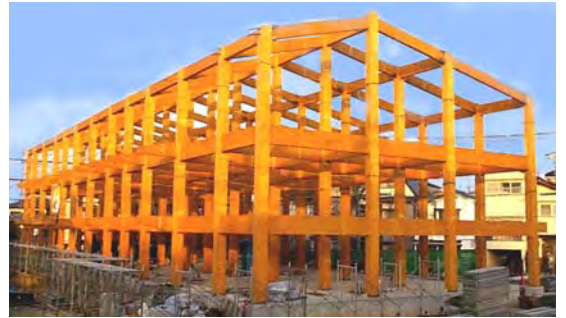
新築段階(部材の製造・輸送、施工)でCO 2 排出量の少ない、木造公営住宅
