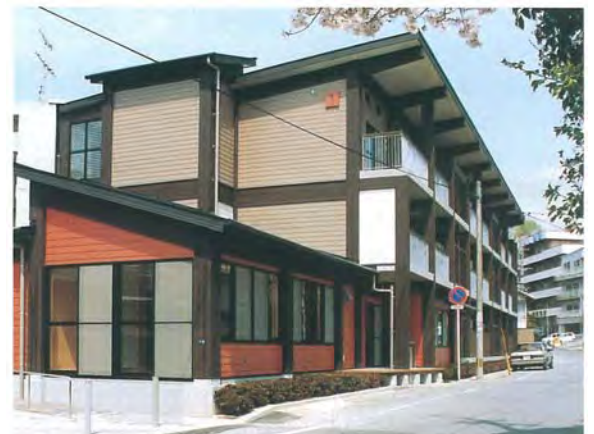
周辺への工事影響抑制を考慮した木造 3 階建て共同住宅 (長崎県営本原団地)
