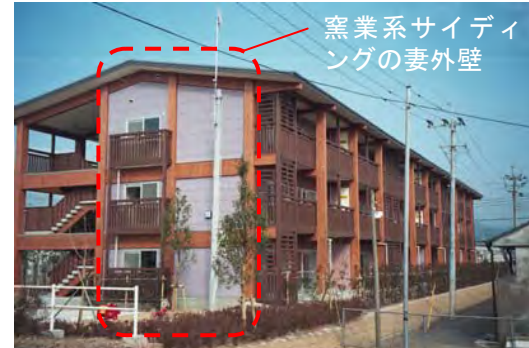
外壁の耐久性を高めるため、妻外壁は窯業系サイディングとした事例
