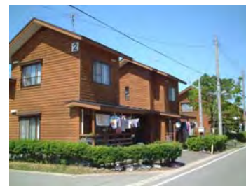
築20年以上経過した木造公営住宅
