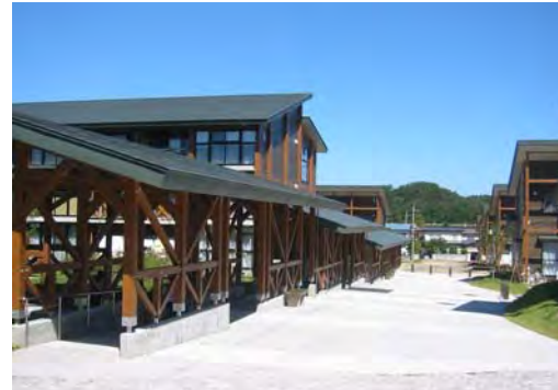
外壁の耐久性を高めるため、大きな庇、雁木を設けた事例
