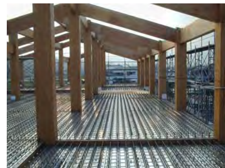
コンクリート床を大断面集成材の柱・梁で支える住宅(工事中の写真)
