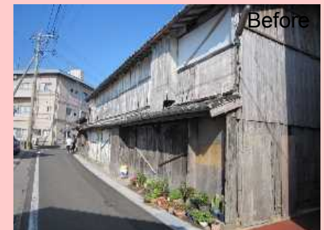
空き家の除却
