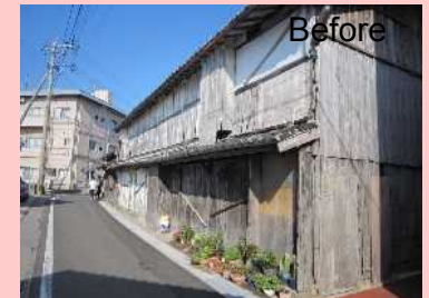
空き家の除却
