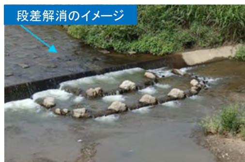
現地発生石を使用した魚道の設置
