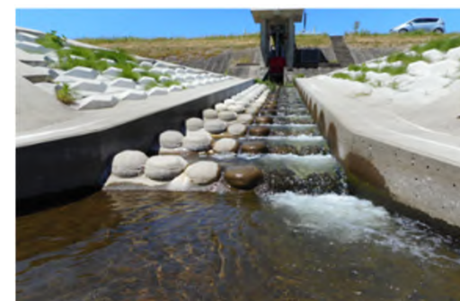
構造物を改修して魚道を設置
