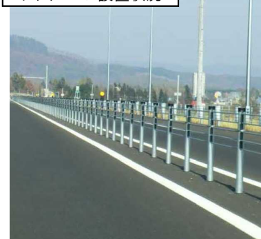
ワイヤロープ設置状況
