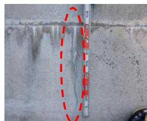
既設ケーソン本体の破損状況
