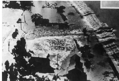
(b) 昭和50年8月洪水 (石狩川 大曲左岸築堤 破堤状況)
