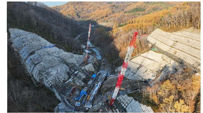
三笠ぽんべつダム本体工事実施状況(R7.11)
