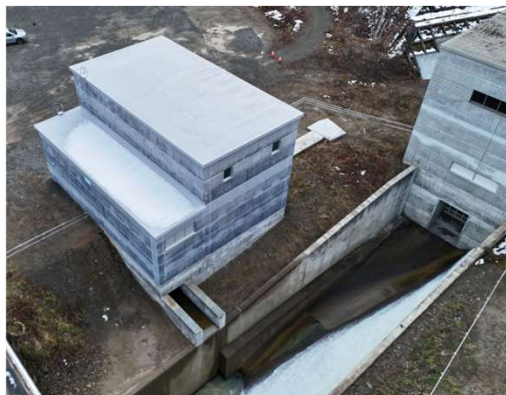
いくしゅんべつ川発電所（工事中）
