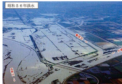
(c) 昭和56年8月上旬洪水 (幌向川氾濫状況)
