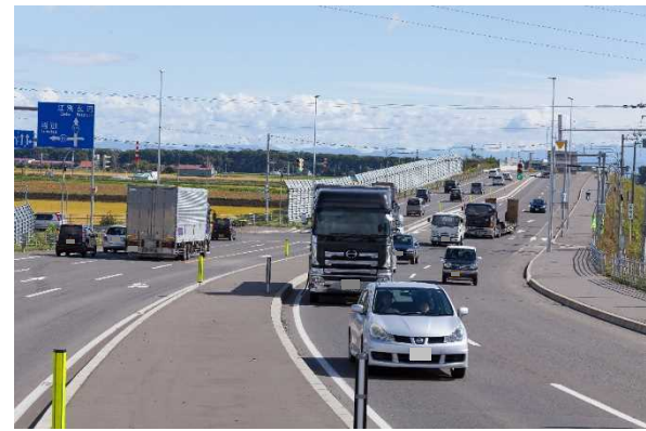
写真：札幌開発建設部（H28.9撮影）
