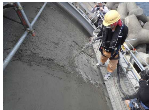
アーチ部の補修状況
