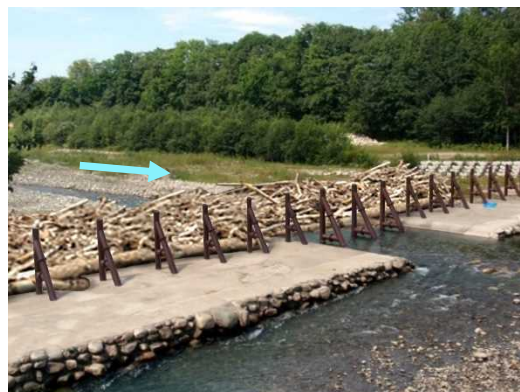
流木対策工 出水後 捕捉イメージ
