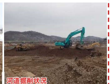
河道掘削状況
