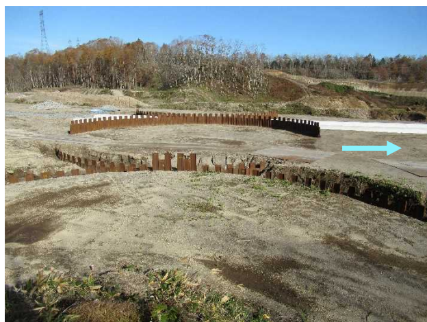
覚生川3号堰堤 施工前
