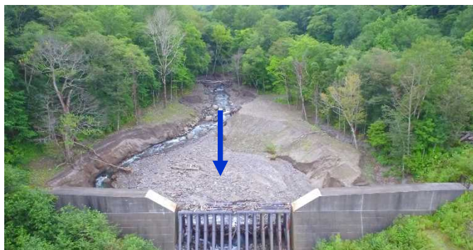
リクマンベツ川第1号堰堤 除石前
