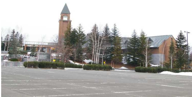
災害時に対応拠点となる公園事務所（ビジターセンター）
