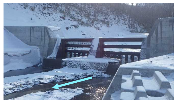
砂防堰堤の整備
