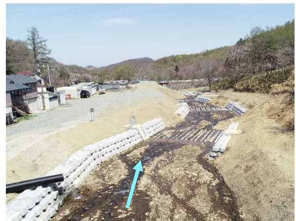
床固工群の整備
