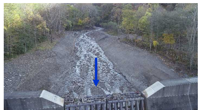
リクマンベツ川第1号堰堤 除石後
