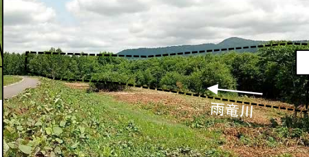
《対策前》清月橋上流側(右岸)
