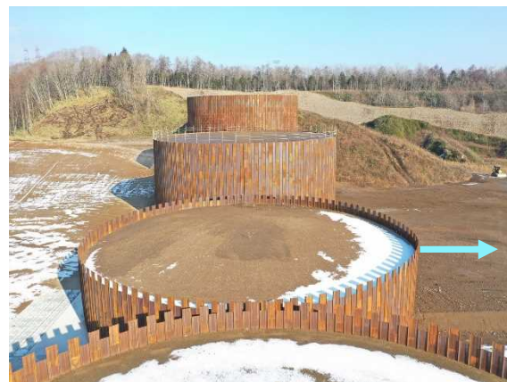
覚生川3号堰堤 施工後
