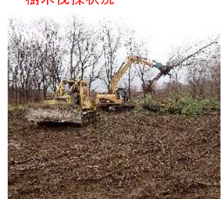
樹木伐採状況
