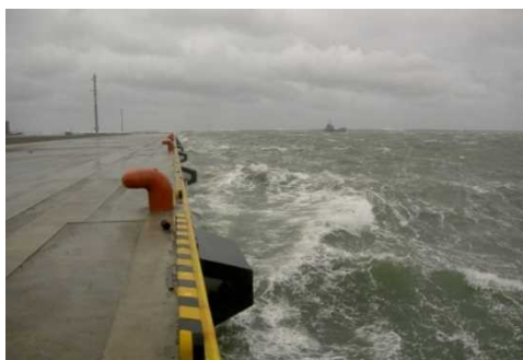
木材チップ荷役岸壁前面の擾乱状況
