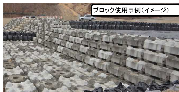
緊急対策用ブロック配置(胆振東部地震後の緊急対策)
