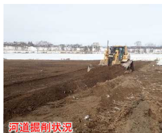
河道掘削状況
