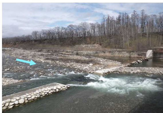
6号床固 流木対策工 着手前
