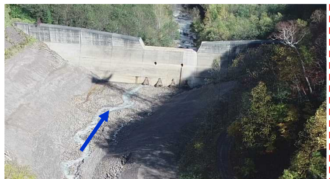
黒岳沢川第1号堰堤 除石後
