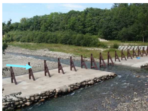
6号床固 流木対策工 完了
