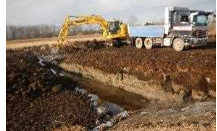
河道掘削・樹木伐採状況
