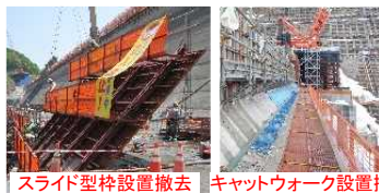
スライド型枠設置撤去
