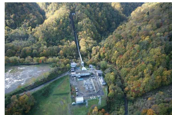
新桂沢発電所（工事中）
