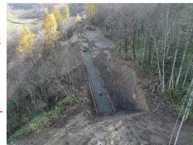
付替林道工事実施状況(R2.11)
