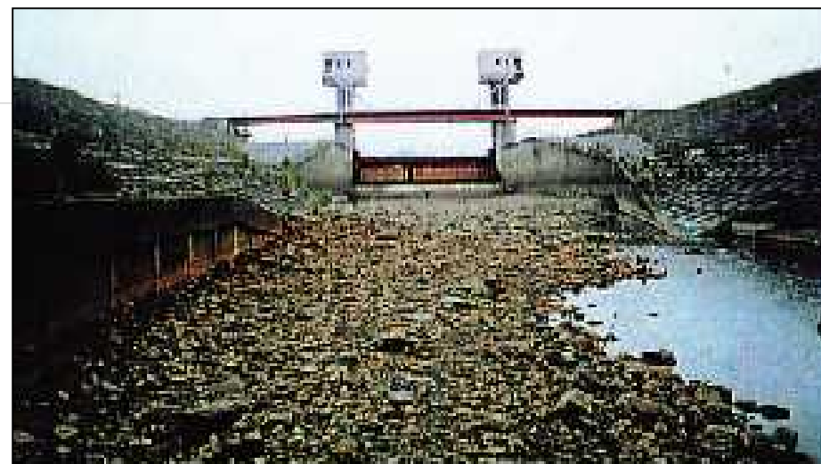
三笠市岡山地先における渇水時の状況 (H10年6月)
