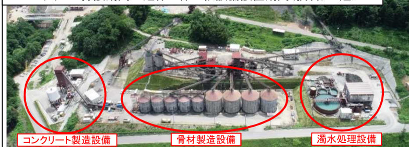
コンクリート打設期間の延伸に伴い仮設備設置期間(損料)が追加
