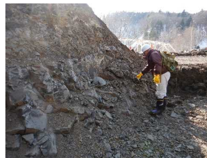
(a)工事施工時の化石調査状況
