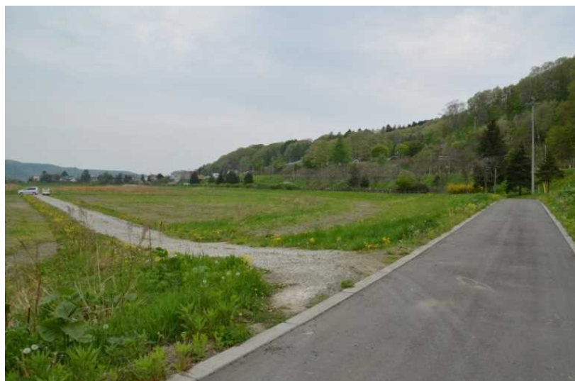
管理用道路における再生骨材の利用状況(本町地区)
