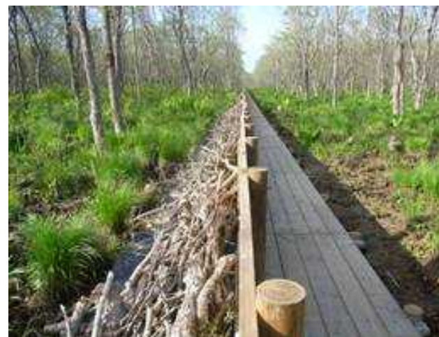
写真 人工ケルミ設置の状況
