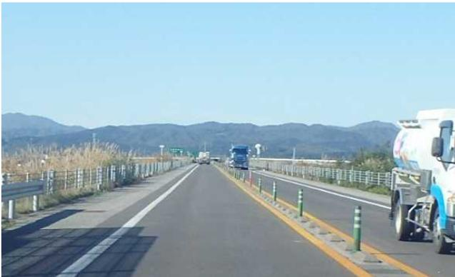
[変更工法] ワイヤロープによる分離構造
