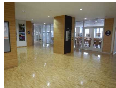
内装の木質化
