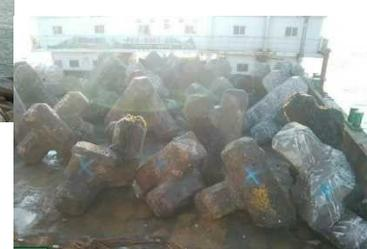
既設消波ブロックの破損状況
