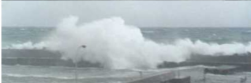
防波堤からの越波状況
