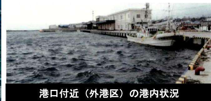
荒天時の港内擾乱状況
