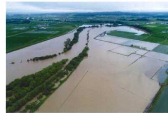
平成30年7月 雨竜川 沼田町共成の氾濫状況
