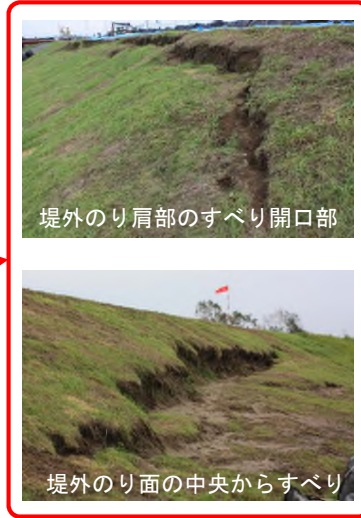
写真 2 - 4 平成28年8月の堤防被災状況
