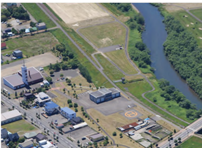
標茶河川防災ステーション
