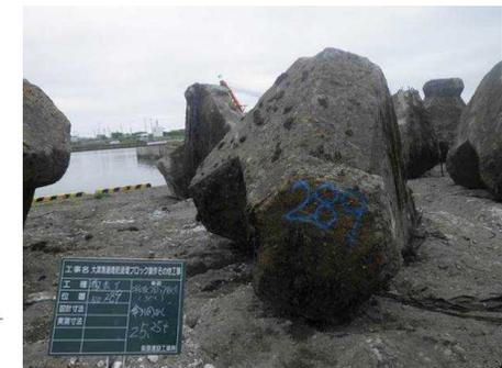
撤去ブロックの破損状況 (流用不可)
