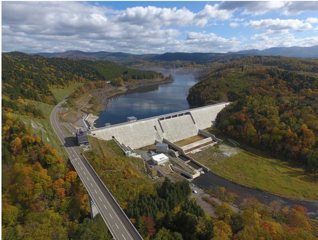
写真1-1 サンプルダムの外観
