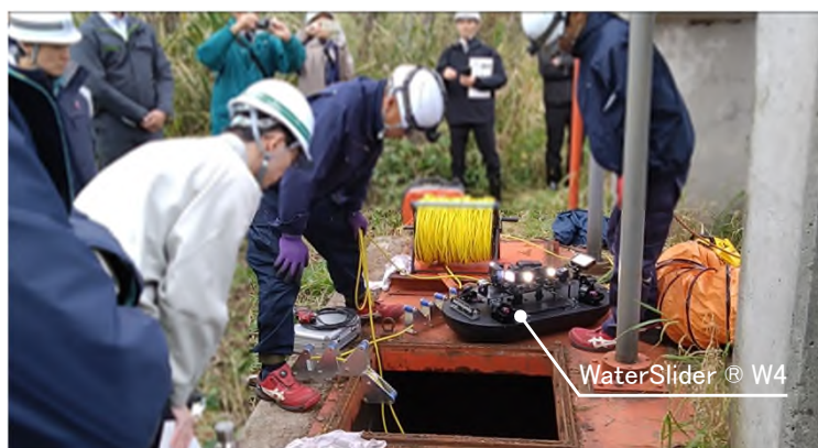
管路内調査デモンストレーション
